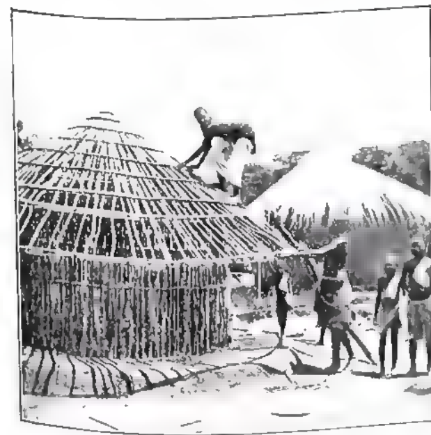
Costruzione di una casa
